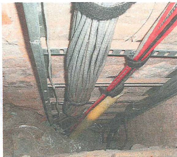
Rook en vuur kunnen zich snel door een gebouw verspreiden wanneer in leidingschachten brandwerende scheidingsen ontbreken tussen verdiepingvloeren.
