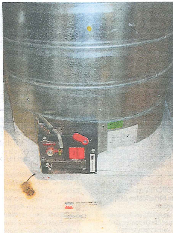
Rook en vuur kunnen zich snel door een gebouw verspreiden wanneer in leidingschachten brandwerende scheidingsen ontbreken tussen verdiepingvloeren.
